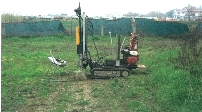
Foto 6. Prova penetrometrica P3
