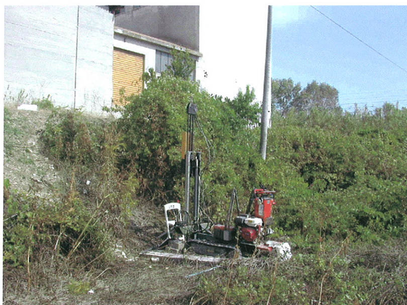
Foto 2. P2 Prova penetrometrica SCPT.
