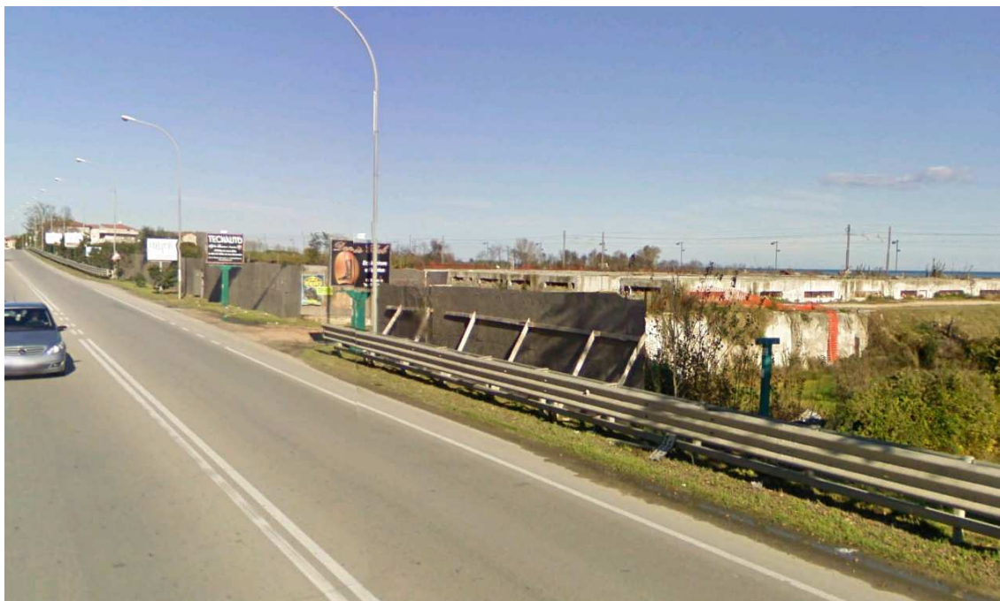
Fig. 3. Vista dell'area dalla SS 16 Adriatica al momento della demolizione dell'ex mangimificio.
