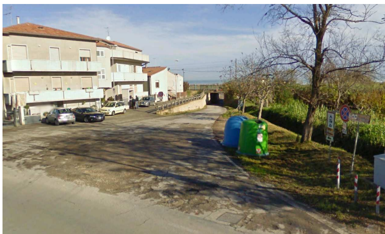
Fig. 14. L'imbocco di via Fonte di Mare: sullo sfondo il sottopasso ferroviario e sulla destra il Fosso Fonte di Mare
