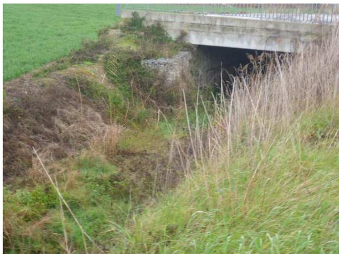
Foto 1: scatolare presente oltre la sezione 80, al di sotto di via Della Pace
