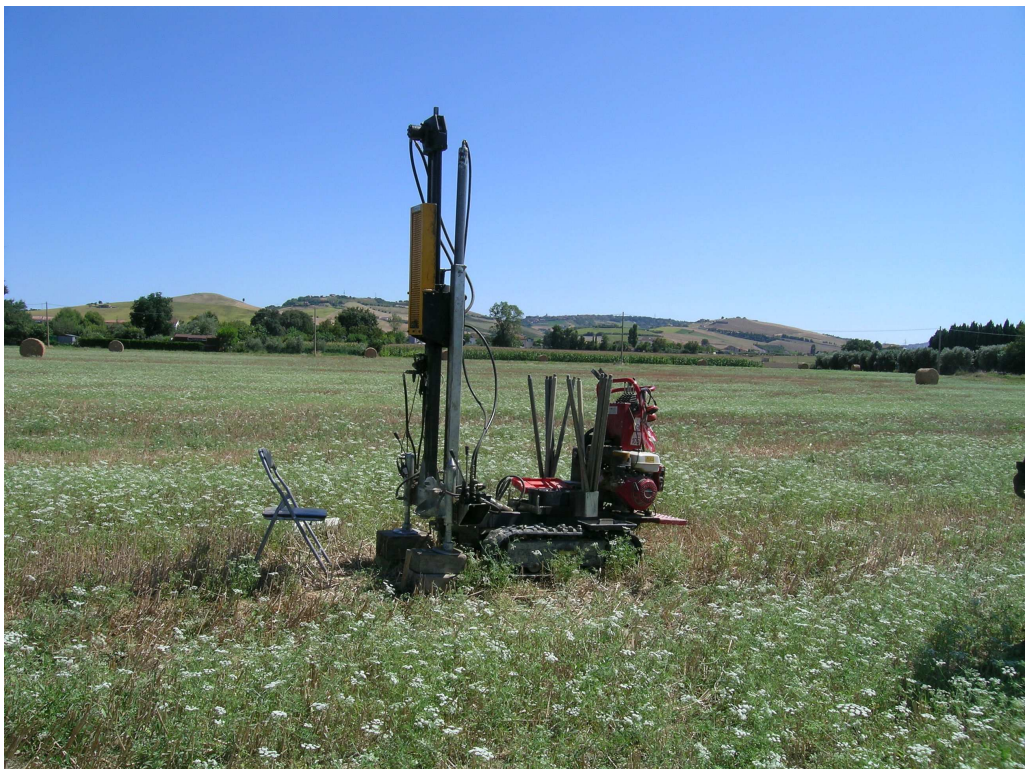
Foto n°50 - Postazione Prova penetrometrica dinamica n°5
