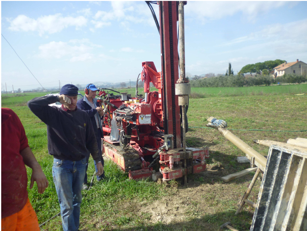
Foto n°1 - Postazione Sondaggio n°10 (Area Ampliamento Marzo 2016)
