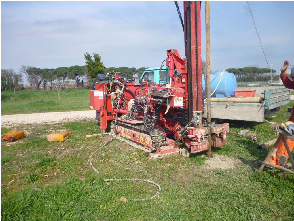
Foto n°7 – Postazione Sondaggio n°12 (Area Ampliamento Marzo 2016)
