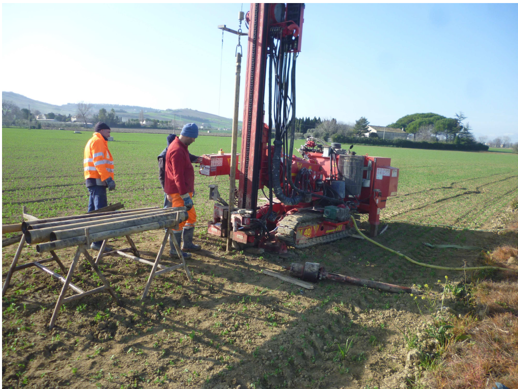
Foto n°4 – Postazione Sondaggio n°11 (Area Ampliamento Marzo 2016)
