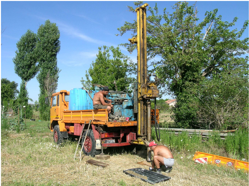
Foto n°4 – Postazione Sondaggio S4
