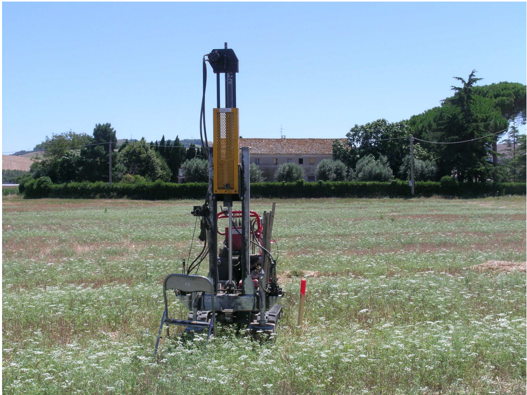
Foto n°49 - Postazione Prova penetrometrica dinamica n°6
