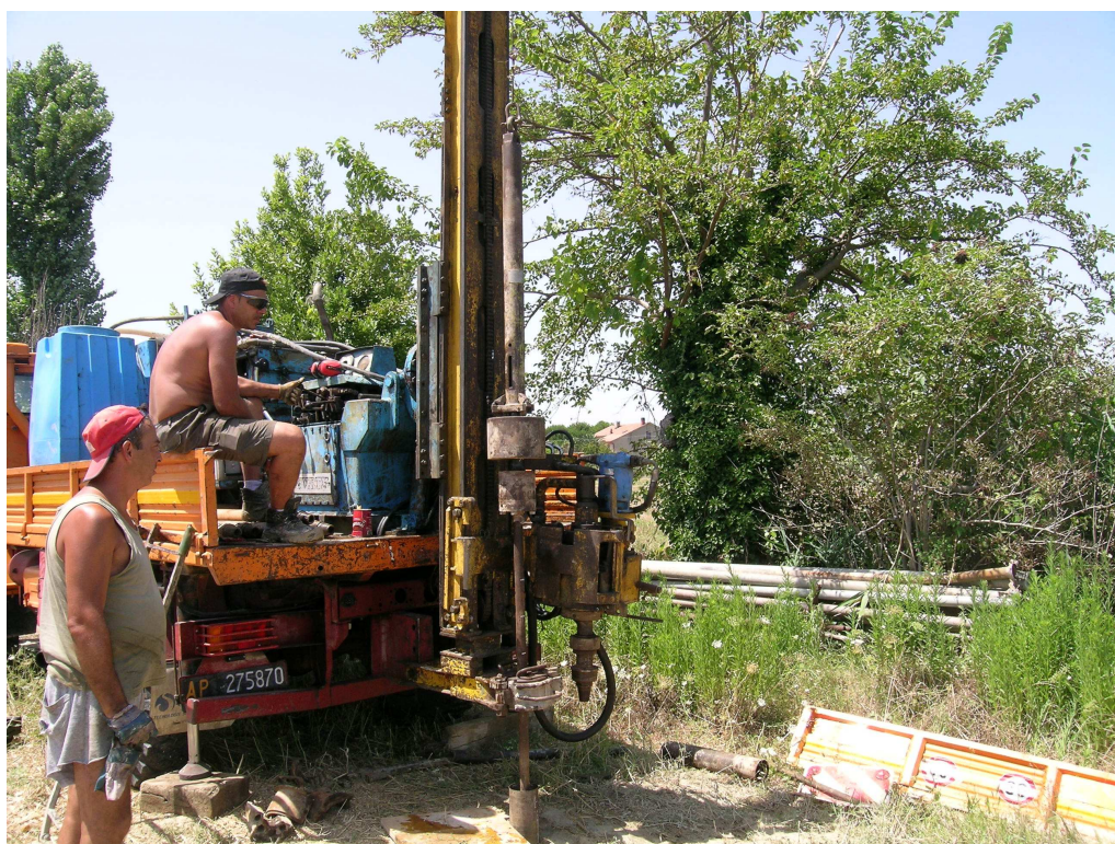
Foto n°6 – Esecuzione della SPT in foro di Sondaggio n° 4 (3.00m – 3.50 m)
