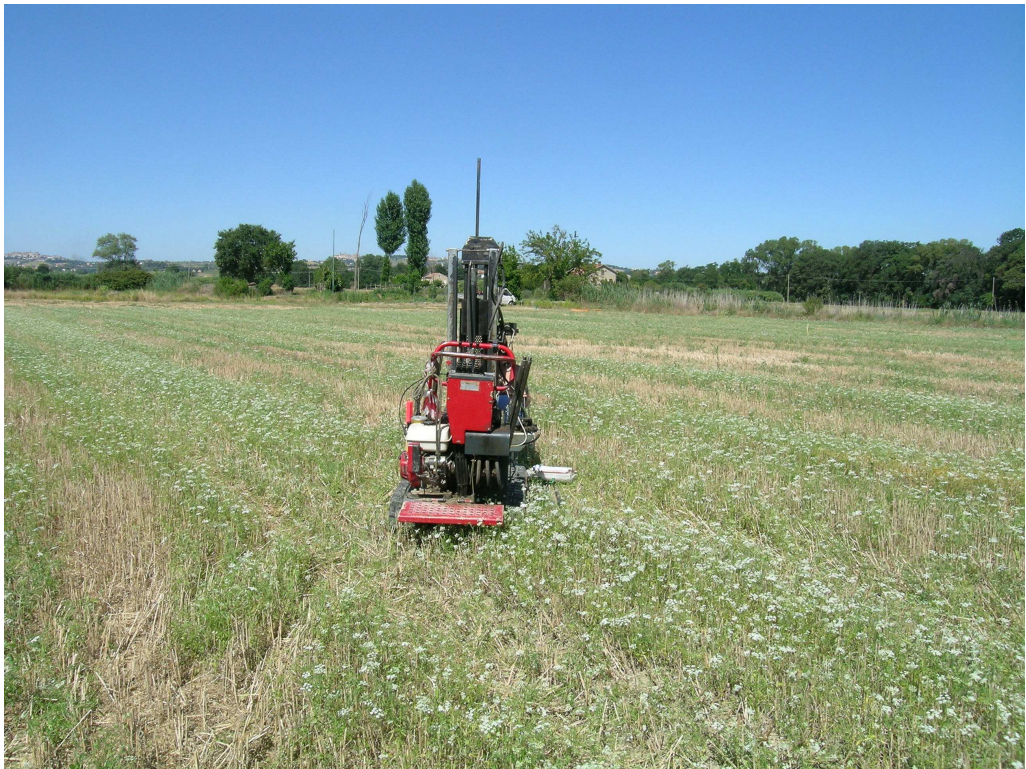
Foto n°48 - Postazione Prova penetrometrica dinamica n°3
