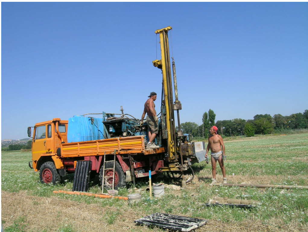
Foto n°24 – SPT in foro di sondaggio (-3.00m a -3.50m)
