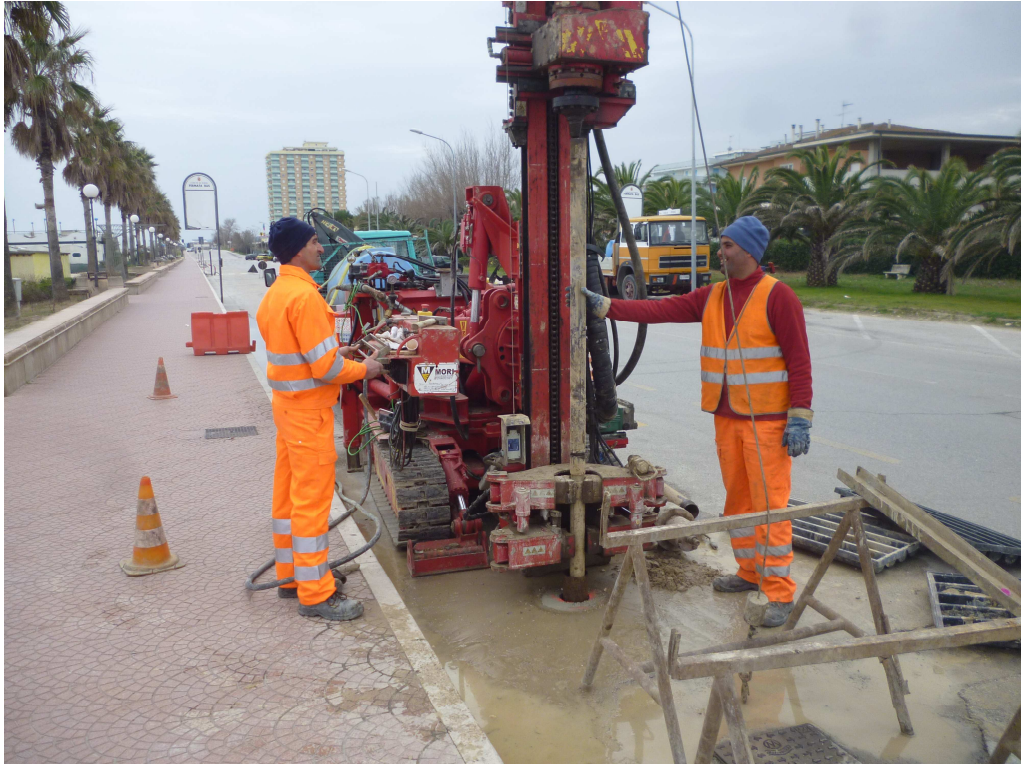
Foto n°1 - Postazione Sondaggio n°sg2 (Area Stazione di Sollevamento IS1 - Marzo 2016)
