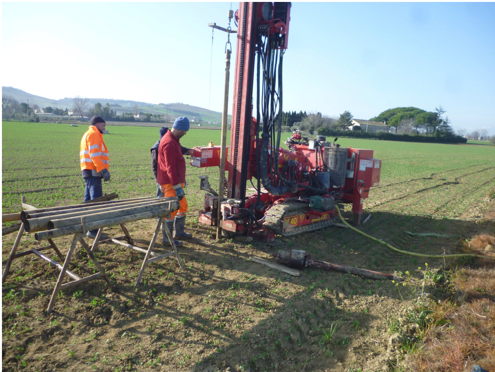
Foto n°7 – Postazione Sondaggio n°sg12 (Area Ampliamento Marzo 2016)
