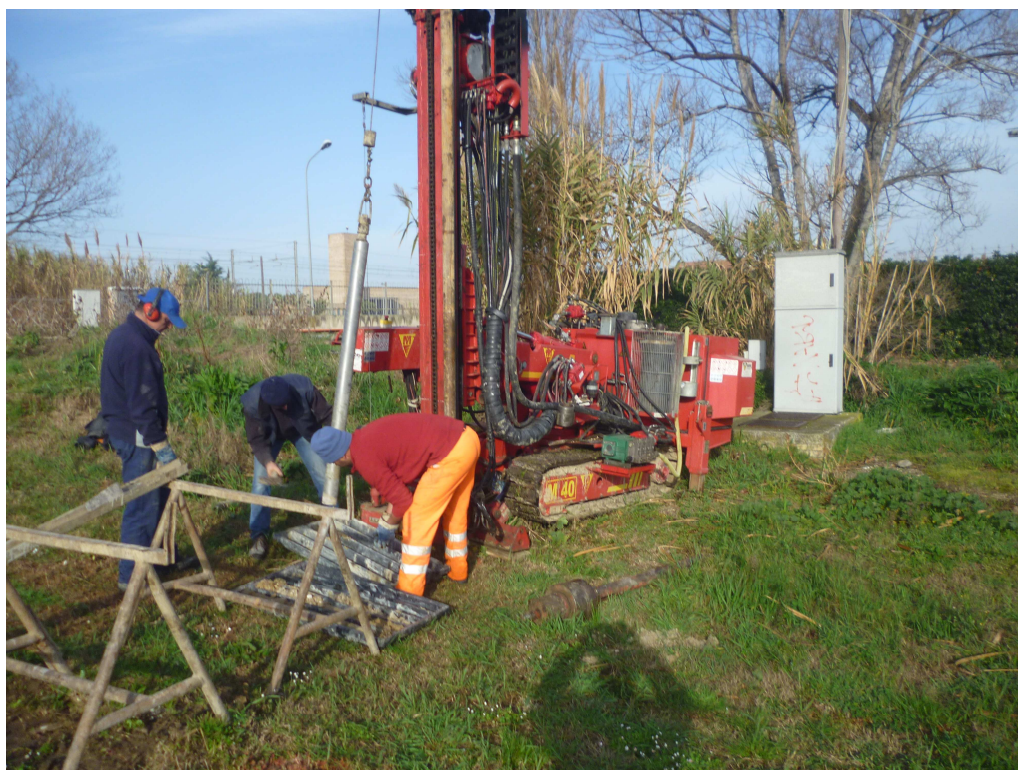
Foto n°4 – Postazione Sondaggio n°sg8 (Area Stazione di Sollevamento IS2 - Marzo 2016)
