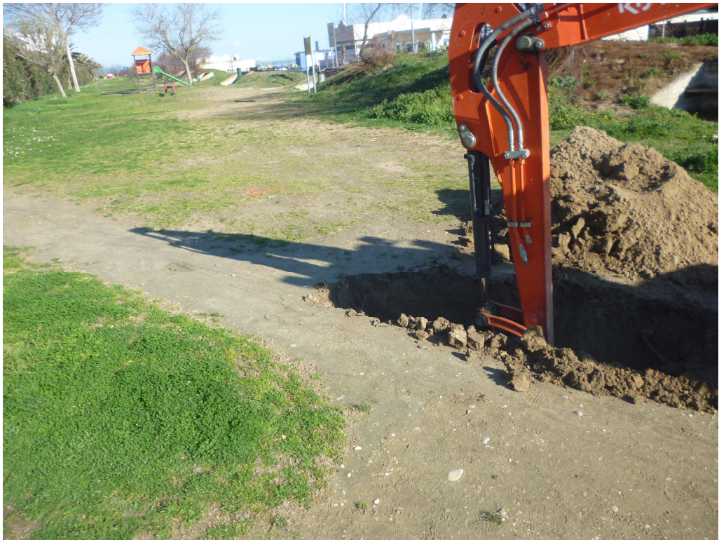
Foto n°11 – Panoramica postazione scavo n°sa3 – Area Pratone Sud
