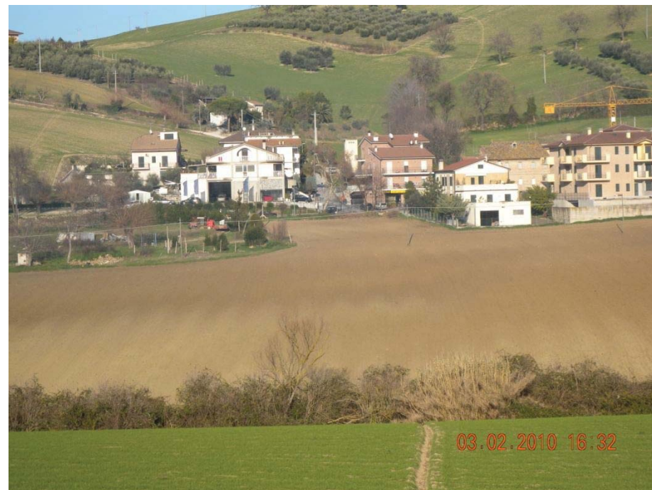
Figura 17, STRADA COMUNALE MISERICORDIA, VISTA SULLE CASETTE
