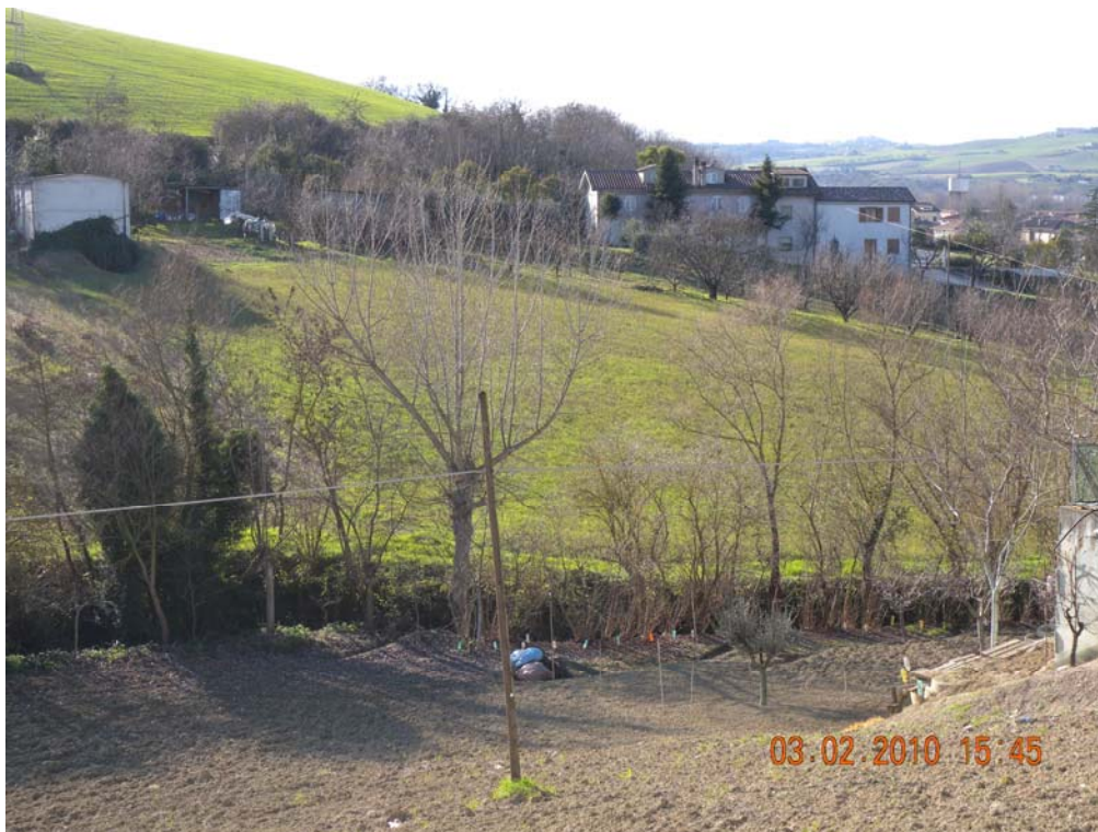
Foto 9, PUNTO N. 7, VEDUTA DEL FOSSO/CANALE
